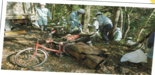
不法投棄された廃棄物の撤去作業
