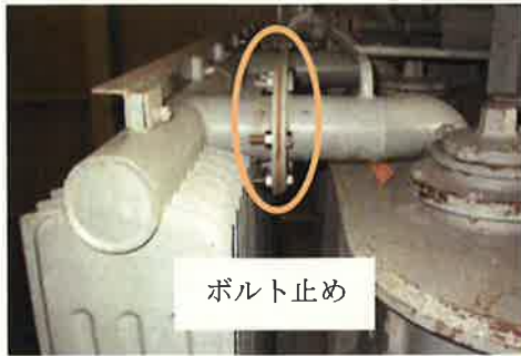
図 8. 放熱器と管体との接続例
