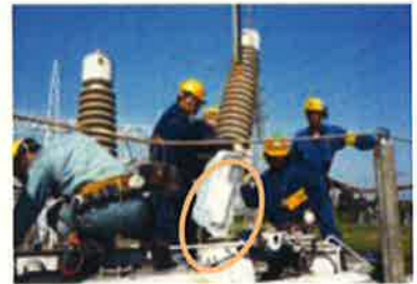
図 9. ブッシングの養生例
