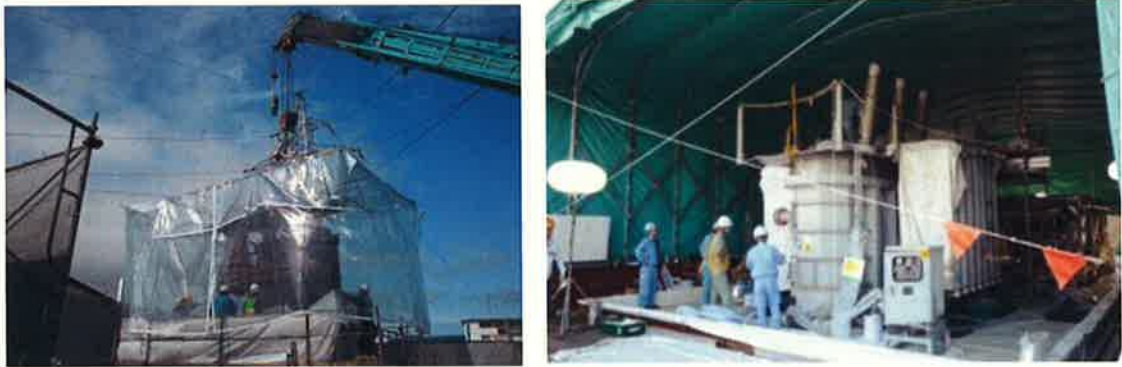
図 10. 養生テントの設置例 (左：仮設テント、右：テントハウス)
