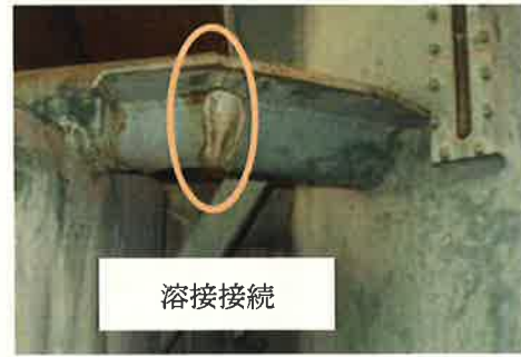
図 8. 放熱器と管体との接続例
